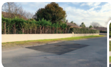
▲ Réfection des regards d'eaux pluviales - chemin des Airelles
