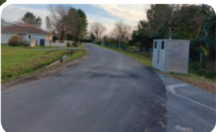
▲ Réfection du chemin de Louise (tronçon avenue de Bordeaux - chemin d'Andrillon)
