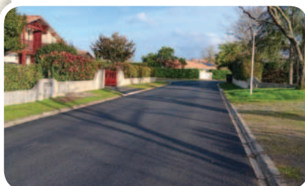
▲ Réfection de la rue de l'Orée (tronçon impasse des Genêts/ chemin du Pignada)
