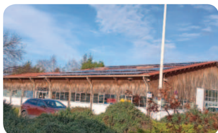
▲ Rénovation énergétique du dojo et de la salle de danse et installation de panneaux photovoltaïques
