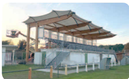
▲ Rénovation des tribunes du stade Roger Labat. La réfection des assises, la peinture de la façade et la remise en état des enrobés devant les tribunes seront prochainement réalisés.
