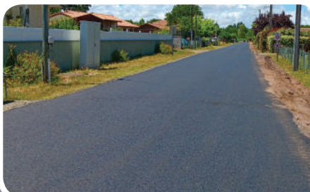
▲ Réfection de la chaussée, rue de Beyriques
