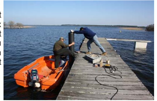
Mise en place des pontons
