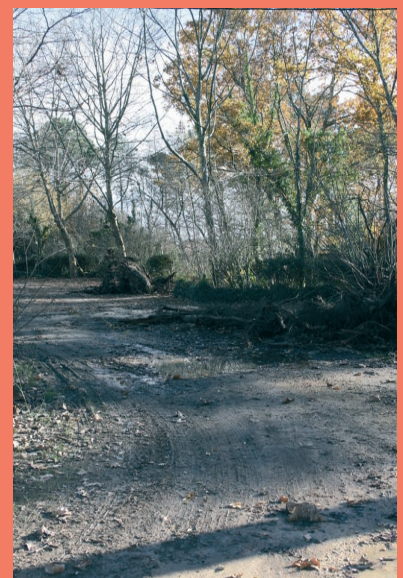
Travaux de dessouchage
